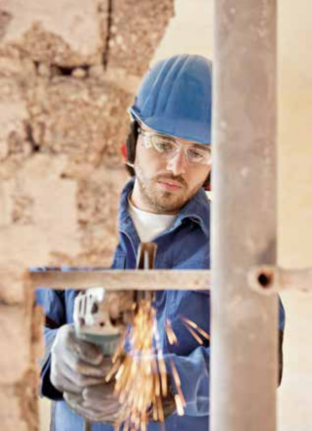
Auch umfangreiche Modernisierungsmaßnahmen zählen zum Leistungsspektrum der RHZ Handwerks-Zentrum GmbH. Rund 680 waren es im Jahr 2019
